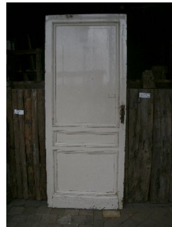
Fi/Ta Tür ohne Pfalz ohne Holzschäden
