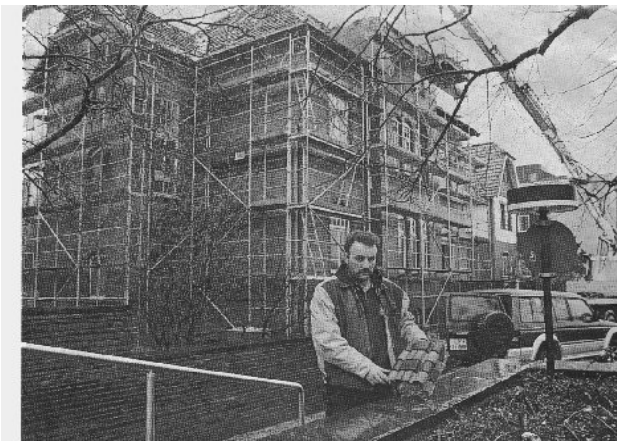
Martin Blöcher mit einem Verbund von Formziegeln vor dem Haus Treppenstraße 15, dessen Außenfassade – darunter sitzt ein weiteres Ziegelmauerwerk – in den nächsten Tagen Stein für Stein abgetragen wird. Foto: Arl
