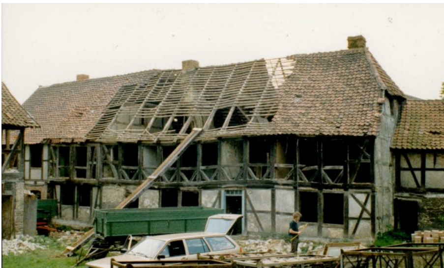
Nebengebäude eines Bauernhofs in Hildesheim wird demontiert
